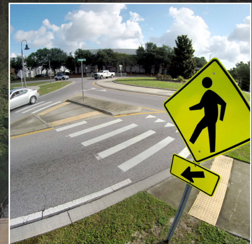
Commons Drive Sidewalks (Complete)
